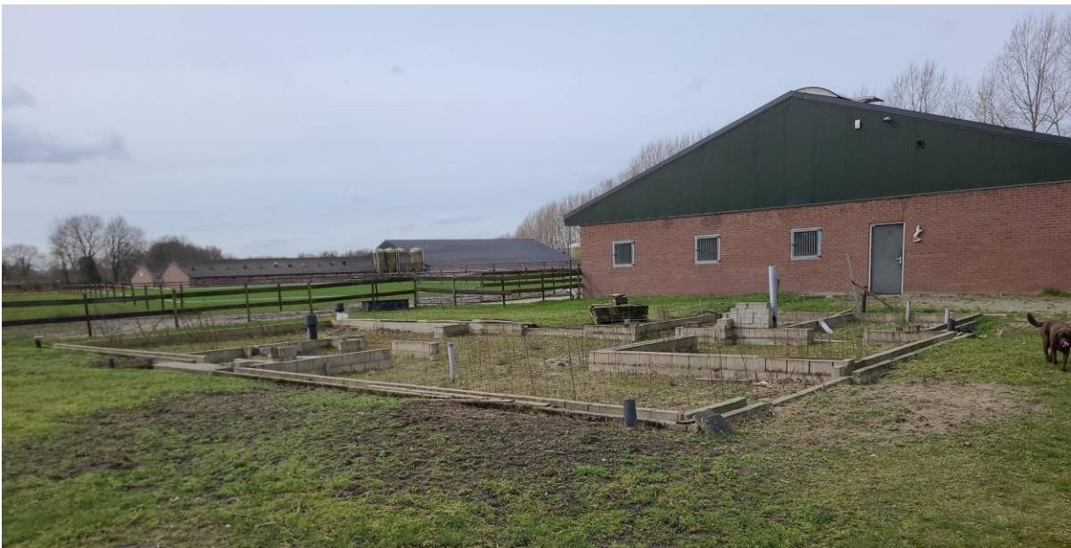
Fundering voor het bouwen van een nieuwe woning / woonboerderij. De leidingen voor riool en hemelwaterafvoer zijn al aangesloten.
