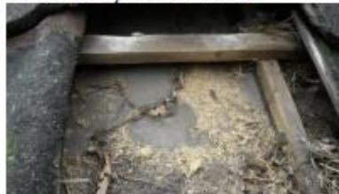
Foto 4 houten dakbeschot woonhuis
