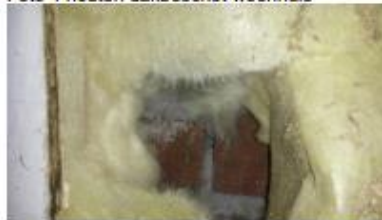
Foto 6 gevels woonhuis houten binnen muur, glaswol en stenen buitenmuur
