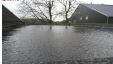
Foto 8 plat dak aanbouw/berging
