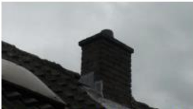
Foto 7 gemetselde schoorsteen met keramisch pijpje
