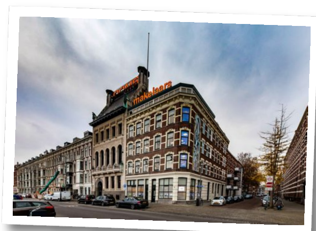
Maaskade 113, 3071 NJ Rotterdam
