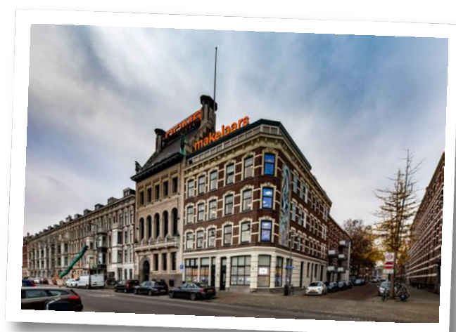
Maaskade 113, 3071 NJ Rotterdam
