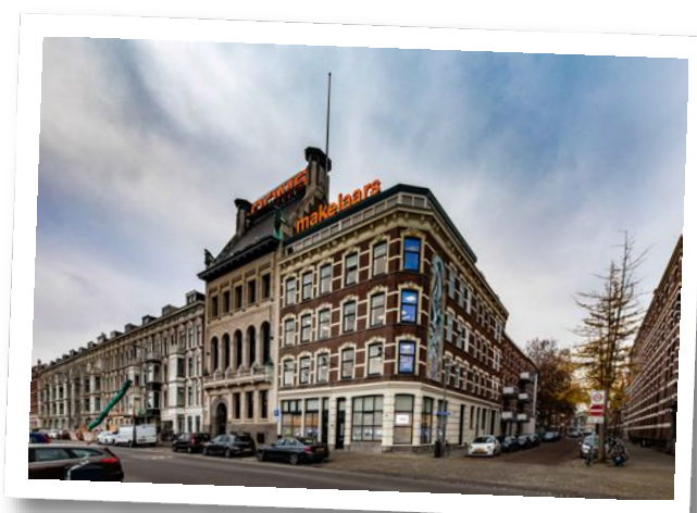
Maaskade 113, 3071 NJ Rotterdam
