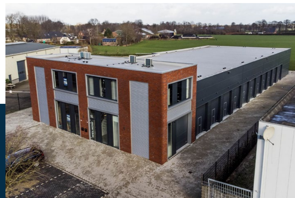
Businesspark Oisterwijk Veldweg te Oisterwijk
