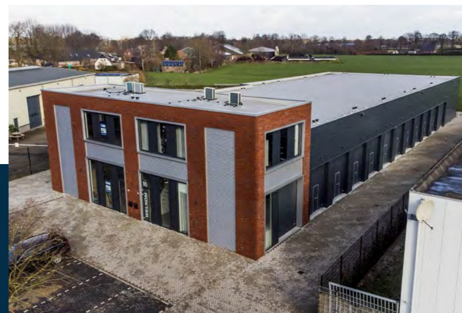
Businesspark Oisterwijk Veldweg te Oisterwijk
