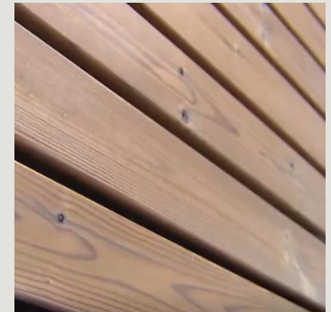
Hout (Voorgevel 2 e verdieping)
