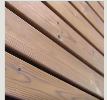
Hout (Gevel 1 e verdieping)
