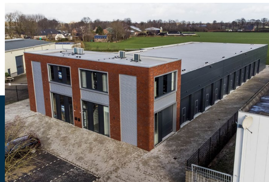
Businesspark Oisterwijk Veldweg te Oisterwijk
