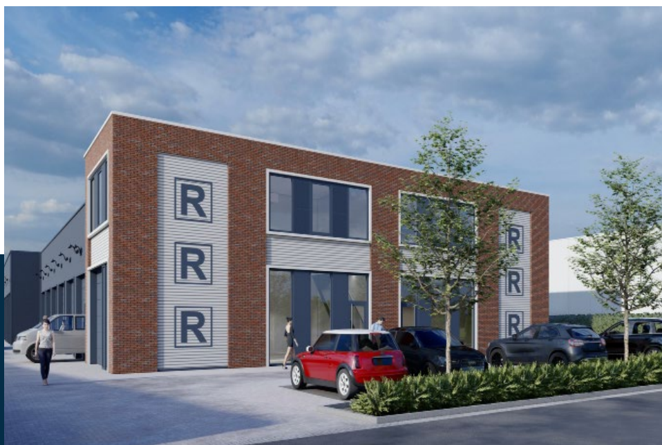
Businesspark Oisterwijk Veldweg te Oisterwijk
