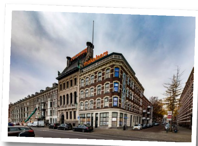
Maaskade 113, 3071 NJ Rotterdam
