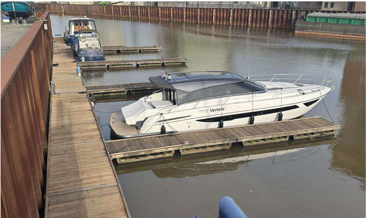
Eigen drijvende aanlegsteigers en 16 ligplaatsen
