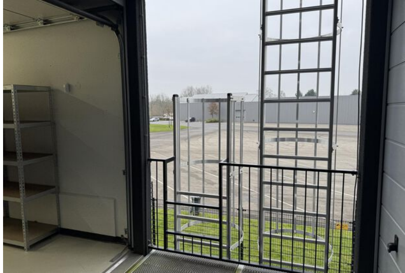
Garagebox eerste verdieping
