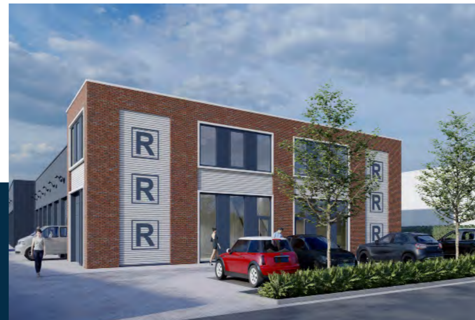
Businesspark Oisterwijk Veldweg te Oisterwijk
