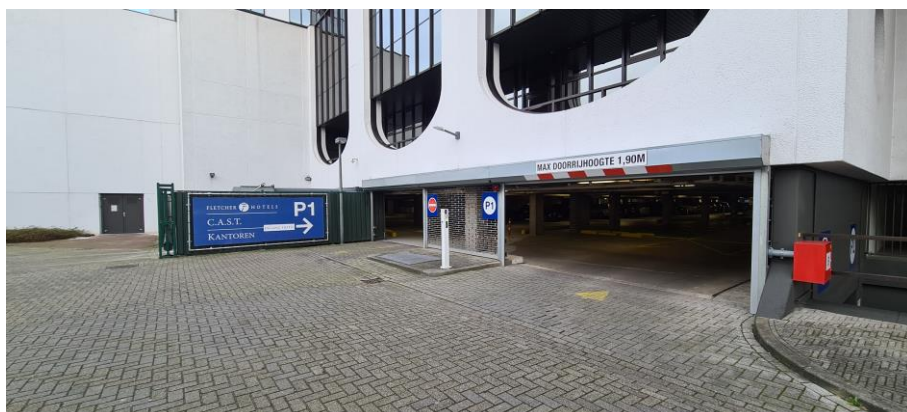
Achterzijde ingang parkeergarage
