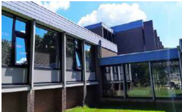
Overgang van de verschillende gebouwdelen.
