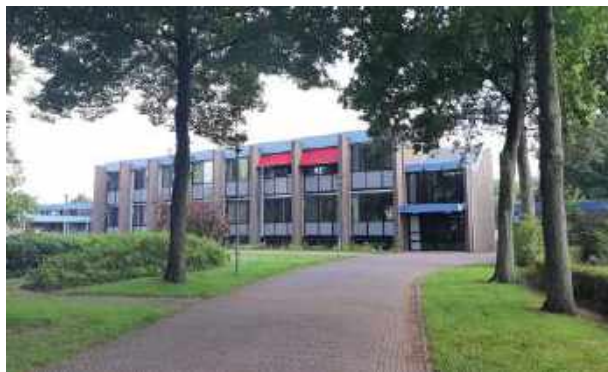
Voorgevel van de kantoorvleugel.
