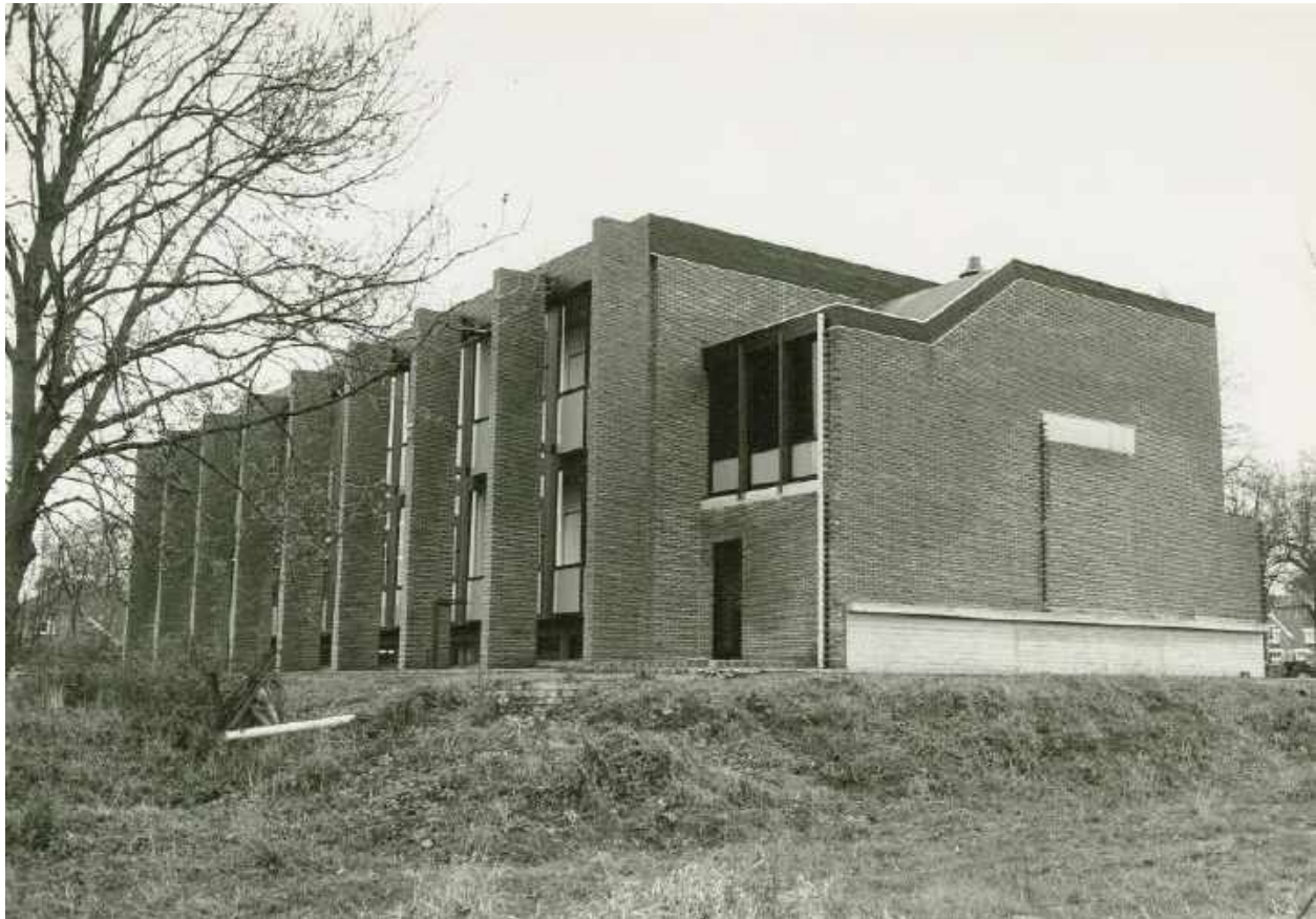
Afbeelding 1: Waterschapsgebouw bij de aanbouw in 1974 (bron: beeldbank Groningen)
