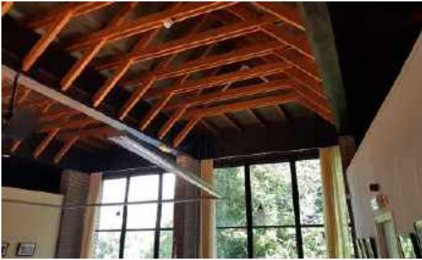
Plafond in de vergaderzaal.
