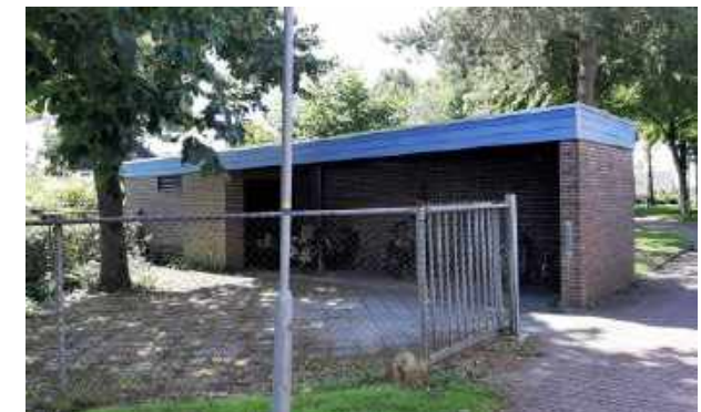
Fietsenberging met transformatorgebouw.
