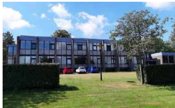
Achtergevel van de kantoorvleugel.
