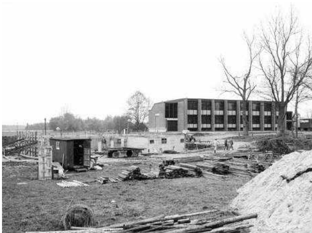
De kantoorvleugel kort na de oplevering in 1972 en de bouw van de tweede fase van het waterschapsgebouw. Foto: M.A. Douma, Collectie Groninger Archieven.
