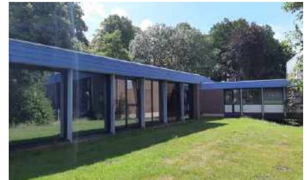
Achtergevel van de bestuursvleugel.
