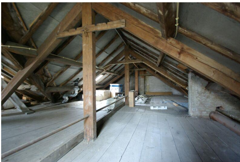
Afbeelding 38 Zolder voorzijde pand, evenwijdig aan de IJsselkade
