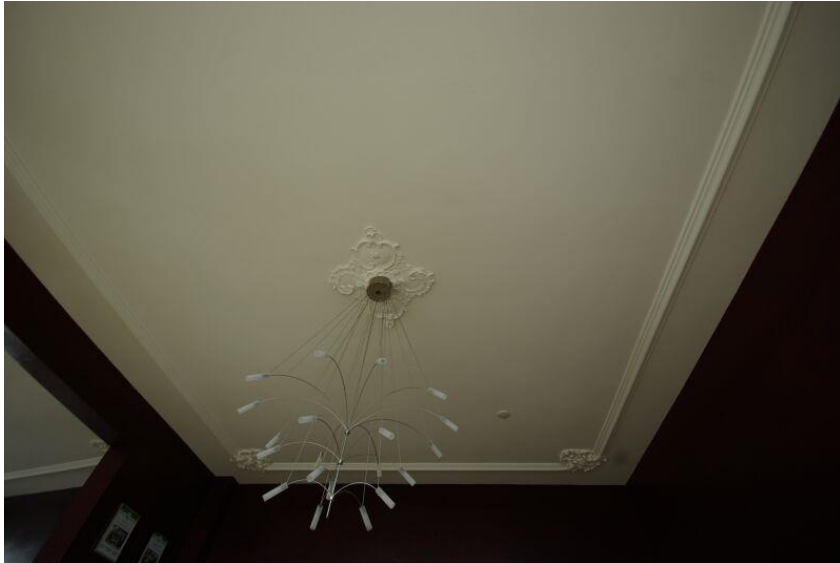
Afbeelding 42 Nieuw aangebracht plafond in ruimte 1.2 en 1.3 Met neorococo versieringen.
