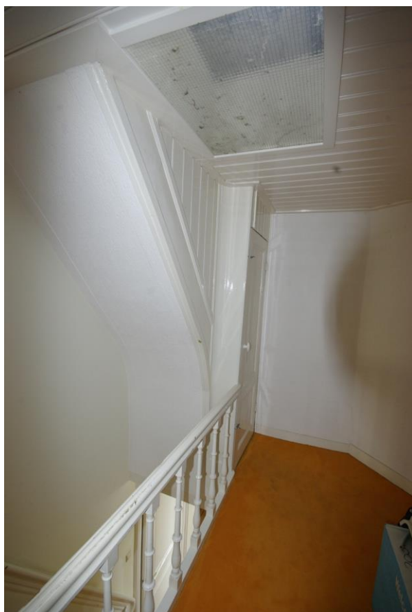
Afbeelding 26. Ruimte 2.1 achter deur de trap naar de zolder.
