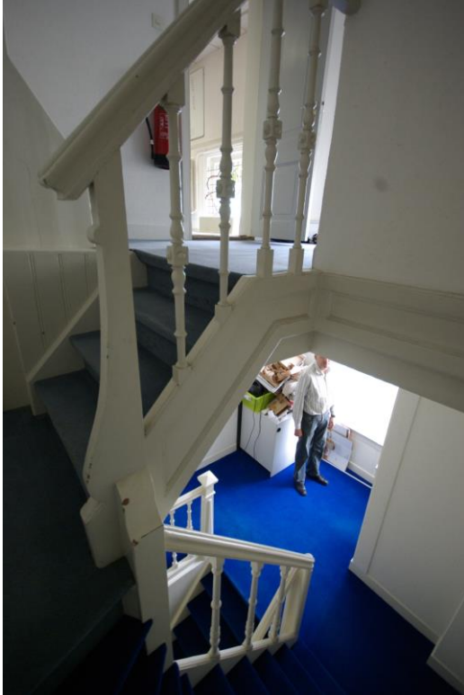
Afbeelding 23. Verschillen in balusters ruimte 1.9
