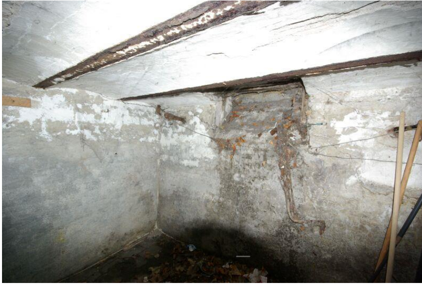
Afbeelding 35 Kelder achterzijde pand, met gemetselde troggewelfjes tussen stalen liggers.
