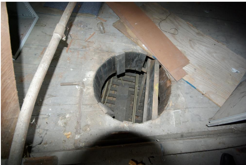
Afbeelding 19. Sparing in zoldervloer ten behoefte van gaslamp.
