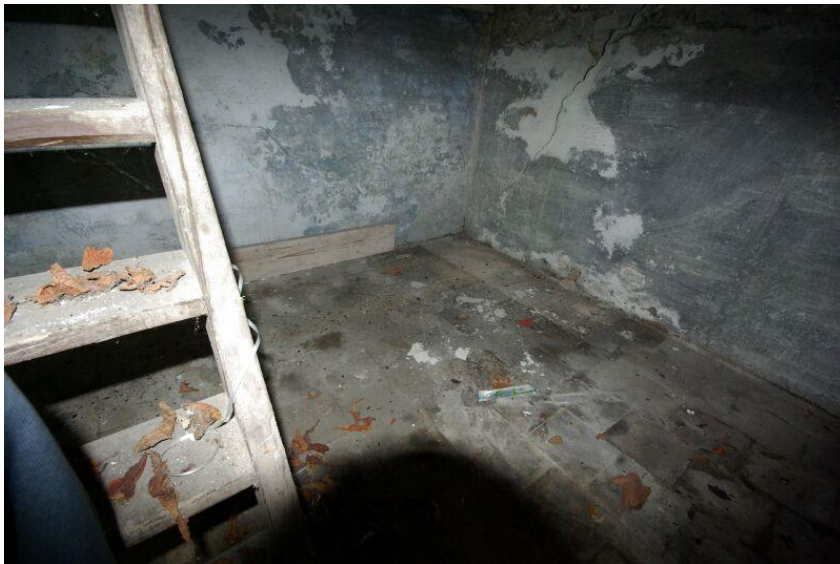
Afbeelding 37 Kelder achterzijde pand.
