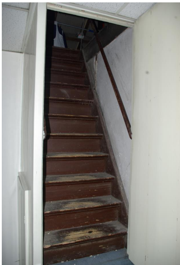
Afbeelding 25. Trap naar de zolder vanaf ruimte 2.5
