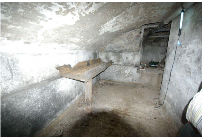
Afbeelding 35 Kelder voorzijde pand met tongewelf.
