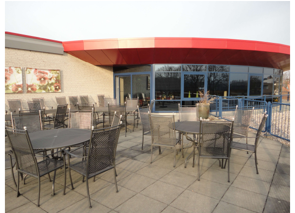
Dakterras 82 m 2 tweede verdieping
