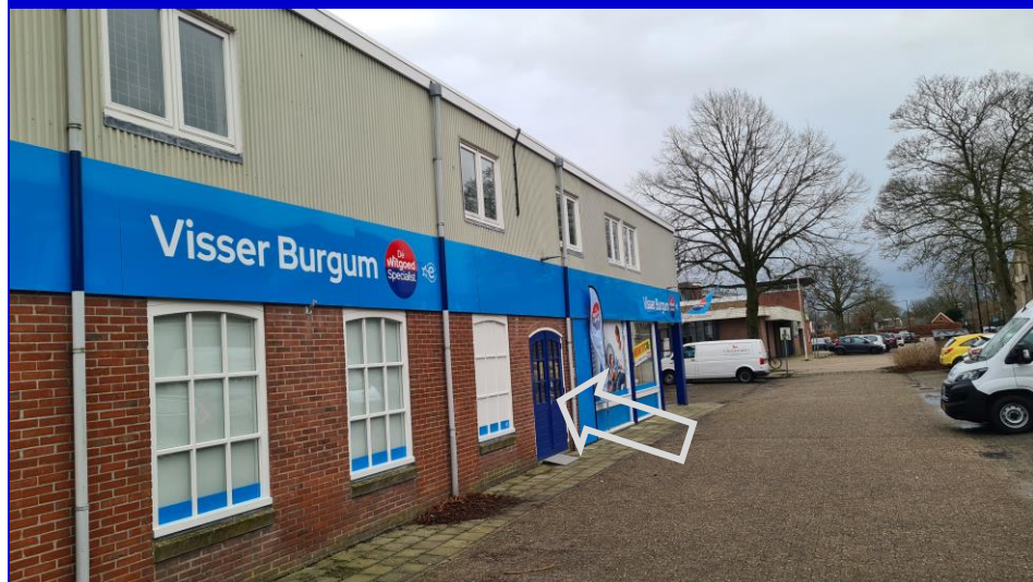
Toegang tot de verdieping via de dubbele deur in de zijgevel
